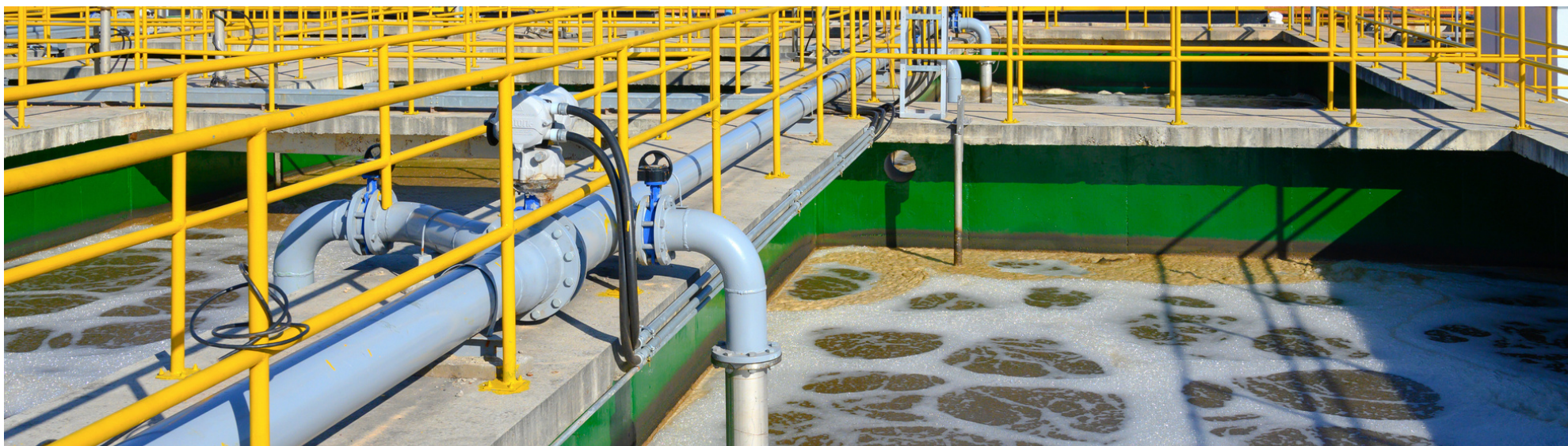
Planta de Tratamiento de Aguas Residuales
